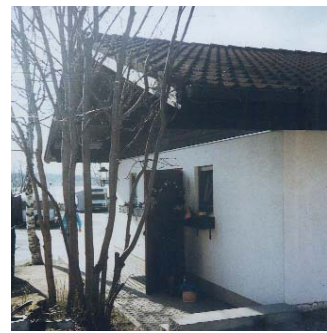
Kleine Waschanlage wurde am 4. Büro angebaut
