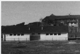
3. Waschhaus mit Duschen und Toiletten
