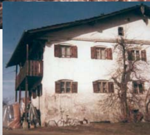
Unser altes Bauernhaus wurde von einem orkanartigen Sturm zerstört
